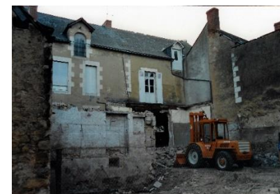
1994 – Travaux d'aménagement de la future boulangerie (Photo Presse)
