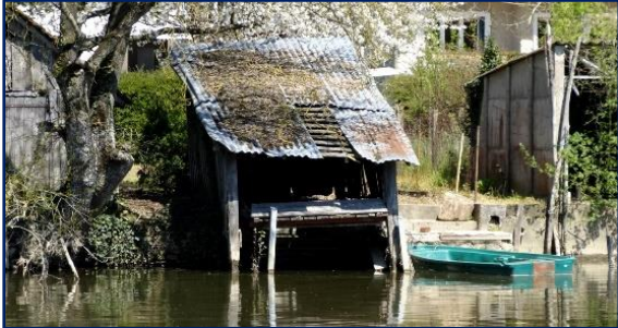
Lavoir existant en août 2020 et ayant disparu en mai 2022 (Photo APSPBC)
